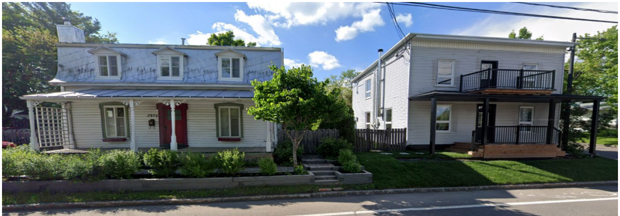
Figure 5- Les maisons sises au 2950 (à gauche) et au 2944 chemin St-Louis (à droite) [Google StreetView, 2022]
