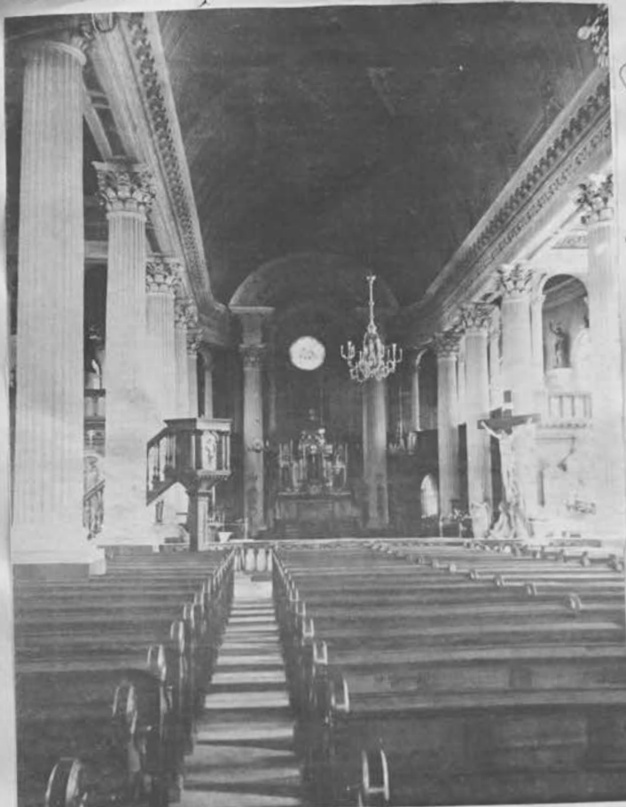
Intérieur de l'église Notre-Dame-de-Foy construite en 1918, d'après les dessins du chanoine H.-A. Scott. Photo prise en 1944.
