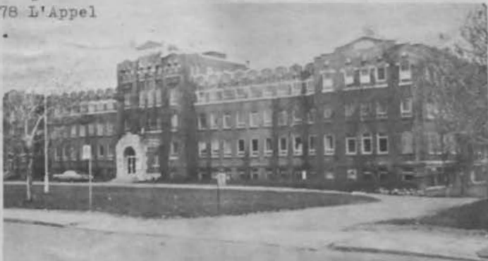
L'ancien Institut Jean-Bosco, du 2160, chemin Sainte-Foy, est devenu le Centre Louis-Hébert, lieu d'accueil pour les handicapés visuels (Photo L'Appel).
