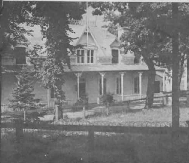
Presbytère Notre-Dame-de-Foy construit en 1698-1699 sur une terre léguée à la paroisse par la famille Pinguel de Sainte-Foy. Allongé du côté ouest en 1841. Transformations au toit. En 1869, changements importants qui ont permis de passer la maison du style tradi-
