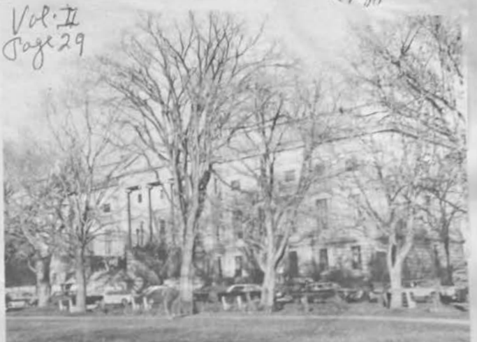
Le Musée actuel du Québec manque des espaces nécessaires à la conservation et à la préservation de ses collections. C'est pourquoi un projet d'agrandissement de plus de $16 millions est en cours. (Photo G. Lefrançois, L'Appel)
