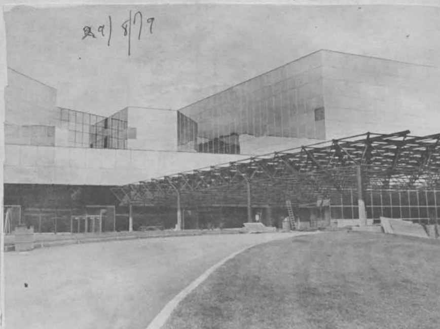
L'entrée principale de l'Édifice du Revenu à Pointe-Sainte-Foy.
