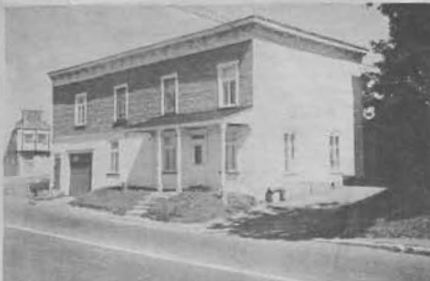
La grande maison à deux logements du 2911, che-
