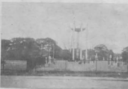
En proie aux "pics" des démolisseurs, le château d'eau de Sillery avait été décapité, à la fin de la semaine dernière, de son réservoir et ne montrait plus que ses longues "jambes".
