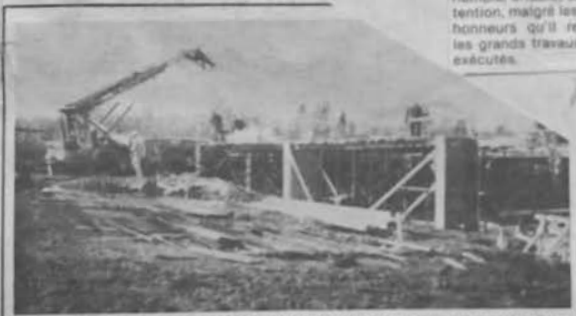
Les travaux de la construction de l'école du Domaine des Soeurs avancent très rapidement. Cette nouvelle école primaire ouvrira ses portes à quelque 500 élèves en septembre 1982. (Photo l'Appel, F. Minvielle).
