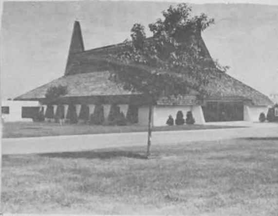
Église de la paroisse Sainte-Geneviève, 3180 rue D'Amours. Elle se dresse en proximité du monument des familles Hamel dont le dévoilement avait lieu récemment. Quant à cette paroisse, elle prit naissance en 1960, ayant été détachée de la paroisse mère de Sainte-Foy. M. l'abbé Léo Letarte y agit comme curé et le père Gilles Jalbert, de la congrégation Mariannhill, comme vicaire.
